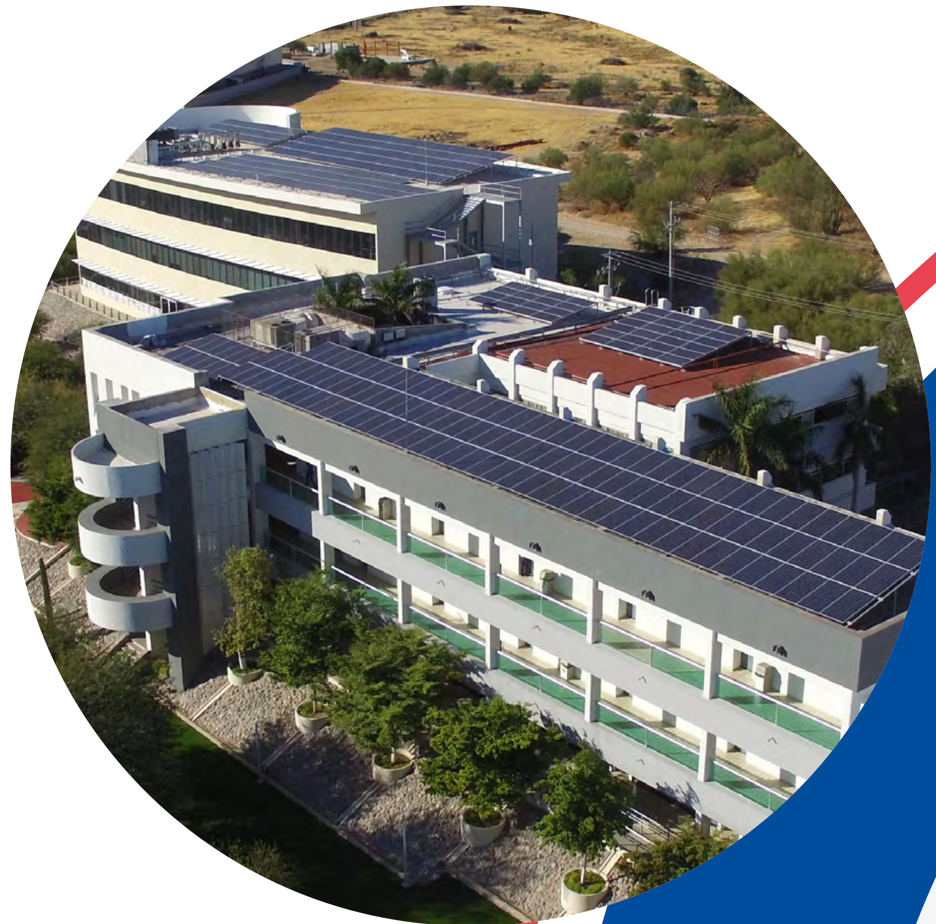
Planta fotovoltaica, Campus Sonora Norte.
