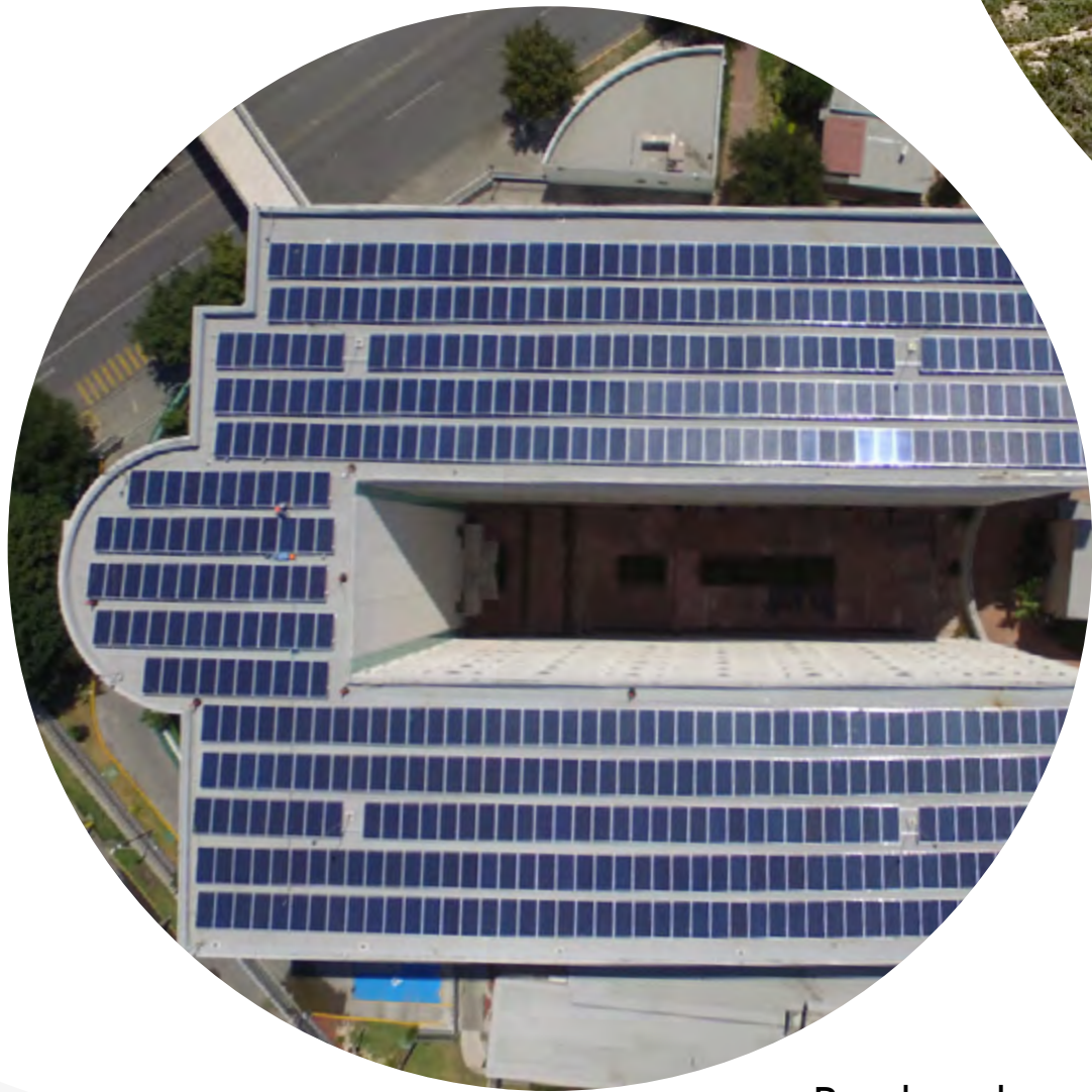
Paneles solares en edificio de residencias, campus Monterrey.
