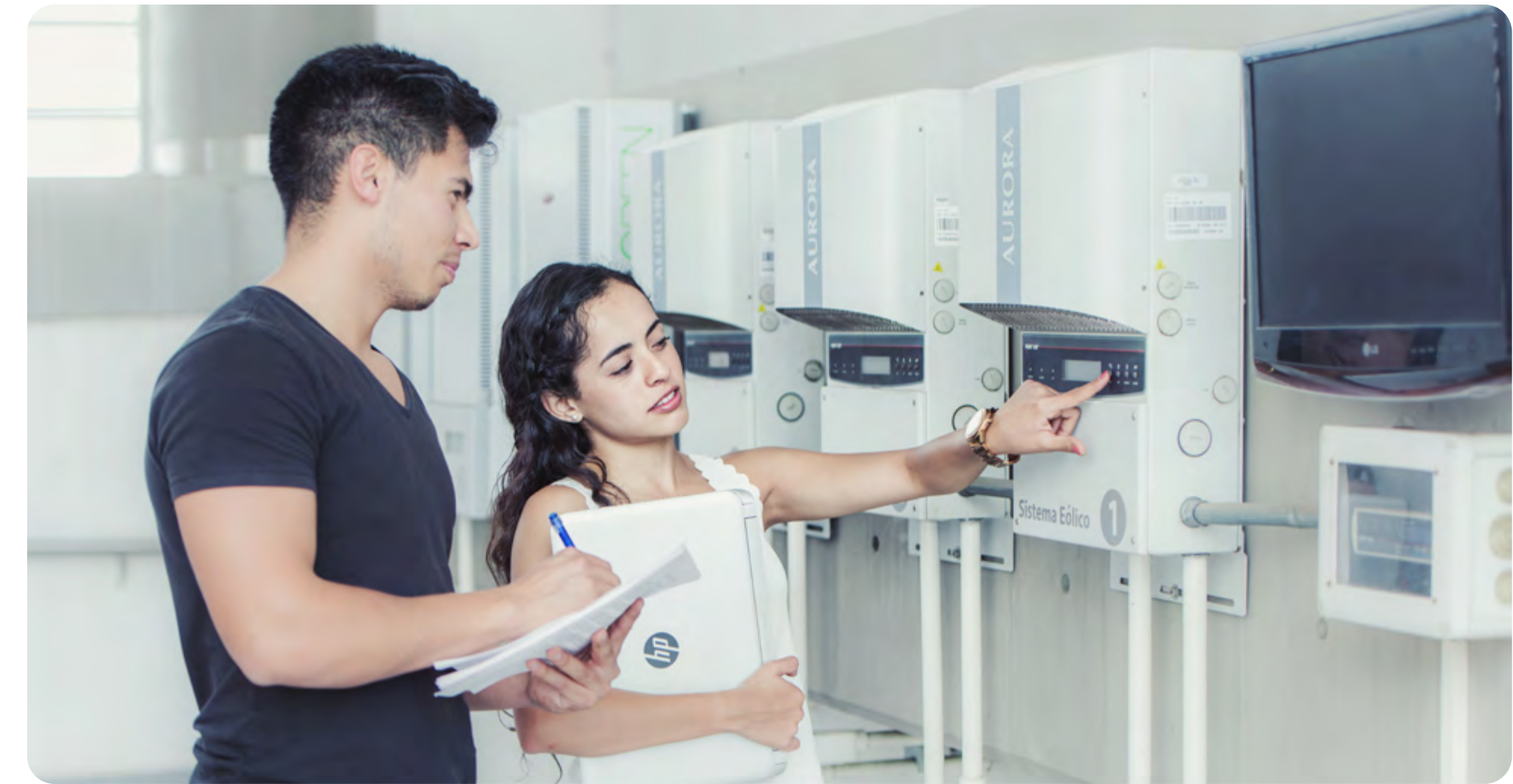
Inversores del sistema eólico, Campus Querétaro.
