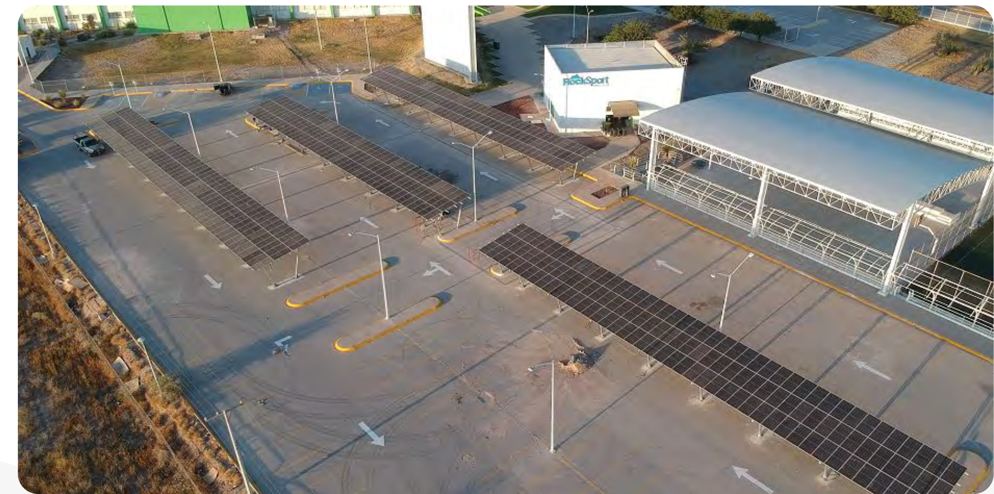
Paneles solares, TecMilenio.
